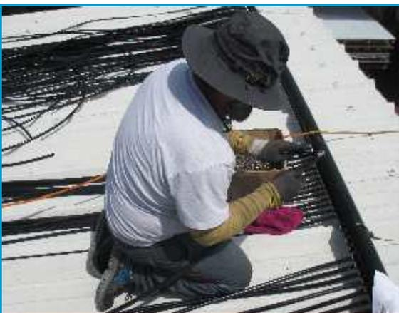
La profondità di inserimento, con un'abbondante tolleranza di +/- 2 cm rispetto alla misura media di 6 cm, rende superfluo rispettare al millimetro la misura di innesto dei tubi.
