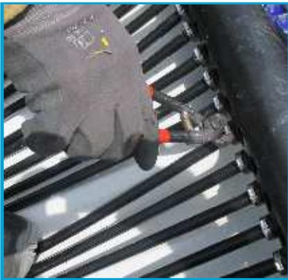
Utilizzare una pinza di crimpatura per schiacciare le fascette stringitubo a un orecchio in acciaio legato. La fascetta stringitubo funge anche da protezione contro i raggi UV e protegge i connettori in gomme EPDM dalle martore.
