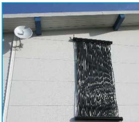
Il montaggio in verticale garantisce un'elevato grado di sicurezza contro lo sfilamento pari a 200 kg/metro lineare
