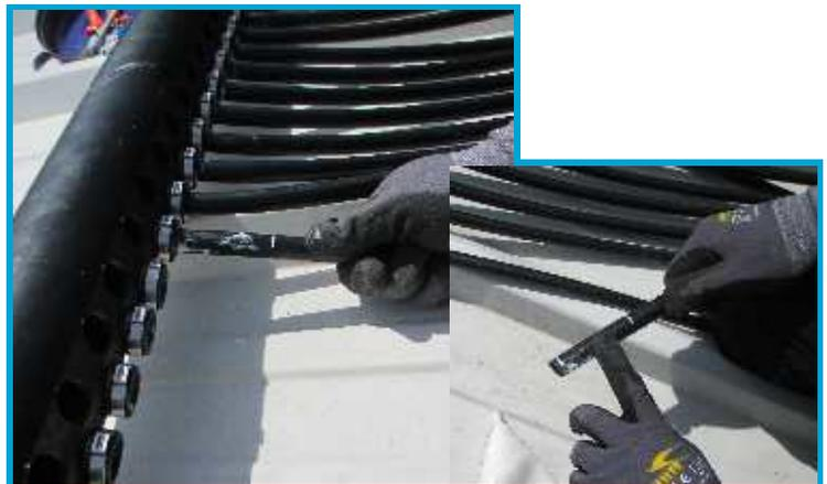
Lubrificare leggermente l'estremità del tubo e il giunto a manicotto con un lubrificante omologato per tubature dell'acqua potabile (sapone in pasta a corredo), per facilitare l'inserimento e l'aggiustamento del tubo.
