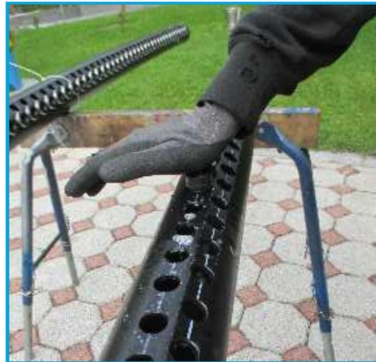
3. Accoppiare i tubi di assorbimento direttamente nel punto di montaggio dell'impianto o a terra (iniziare con la fila inferiore)
