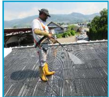
Una persona (peso massimo 110 kg), può camminare senza problemi sulla superficie del Turbosorber, ad esempio per interventi di assistenza o per pulirlo con un pulitore ad alta pressione (max. 150 bar).
