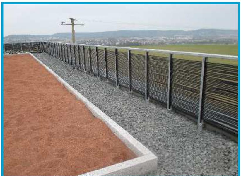
Absorberzaun als Geländersystem mit Sichtschutzfunktion, z. B. für die Regeneration von Eisspeichersystemen oder anderen Anwendungen (mit Spezial-PE-Rohren).
