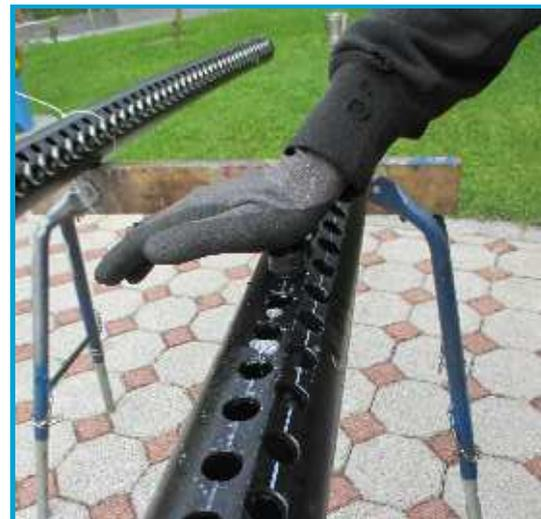
3. Die Absorberrohre am Aufstellort oder bereits am Boden zusammenstecken (untere Reihe zuerst)
