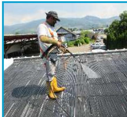
Turbosorber problemlos begebar bis 110 kg Personengewicht, z. B. für Service oder Reinigung mit Hochdruckreiniger (max. 150 bar).
