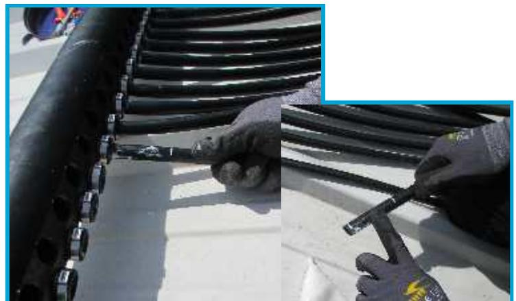
Das Rohrende und die Steckmuffe mit für Trinkwasserleitung zugelassenem Gleitmittel (Pastenseife im Lieferumfang enthalten) leicht auftragen. Das Rohr lässt sich dann leicht einführen und nachregulieren.
