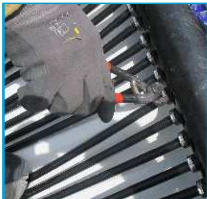
Leichte und schnelle Verpressung der VA Einohrschellen mit Anschlag-Presszange. Die VA Schelle dient zudem als UV-Schutz und Marderschutz für die EPDM Gummisteckverbindungen.
