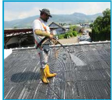
Turbosorber est praticable et supporte des poids allant jusqu'à 110 kg, par ex. pour le S.A.V. ou le nettoyage avec un nettoyeur haute pression (max. 150 bars)
