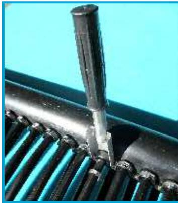
En cas de montage erroné, démonter le collier en inox du connecteur EPDM à l'aide de l'outil à fourche. Ce dernier permet ensuite de retirer facilement le connecteur EPDM qui, ne pouvant pas être endommagé, est donc réutilisable plusieurs fois. Une pince spéciale permet de reformer le collier en inox qui peut lui aussi être réutilisé
