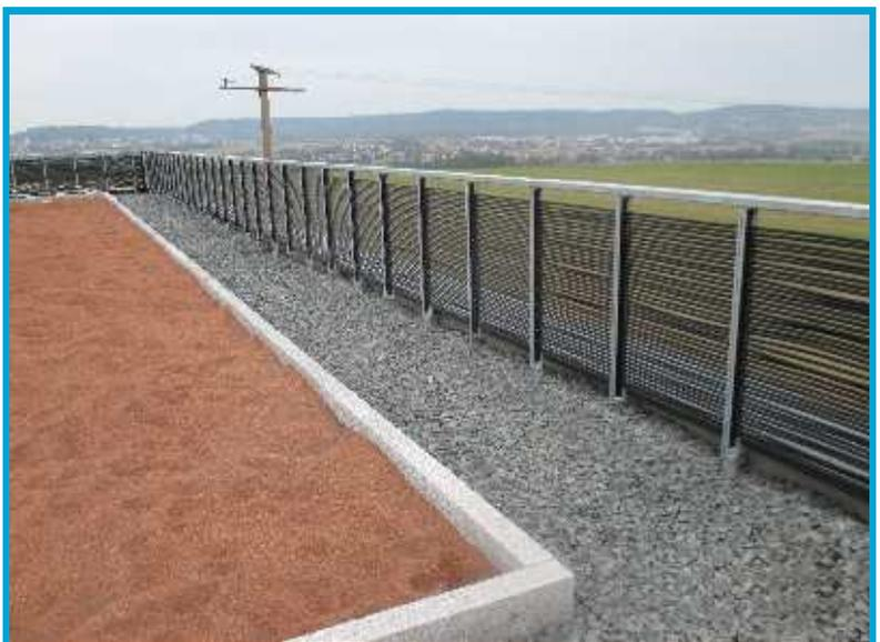
Absorbeur sous forme de clôture occultante, par ex. pour la régénération d'accumulateurs de glace ou toute autre application (avec des tubes PE spéciaux)
