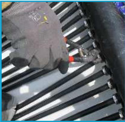
Serrage simple et rapide des colliers à une oreille en inox avec une pince à sertir avec butée. Le collier sert en outre de protection contre les rayons UV et les morsures de fouine pour les connecteurs EPDM.
