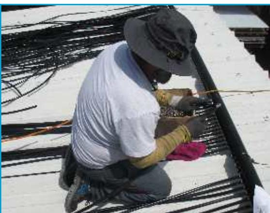
Grâce à la profondeur d'insertion et une large tolérance de +/- 2 cm par rapport à la moyenne de 6 cm, toute mesure au millimètre près est superflue.
