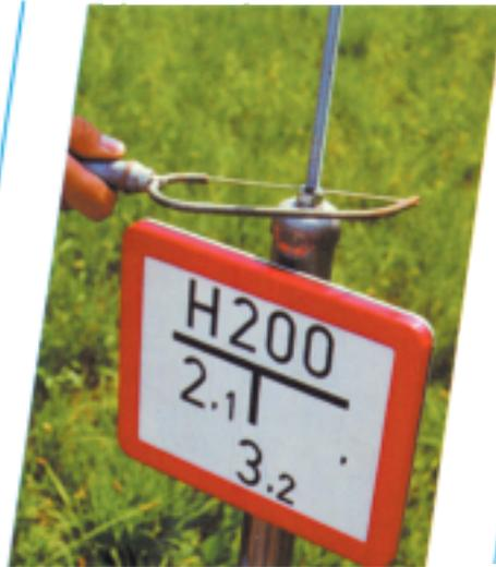
Innerhalb Rohrpfosten von äußeren Einflüssen geschützt.
