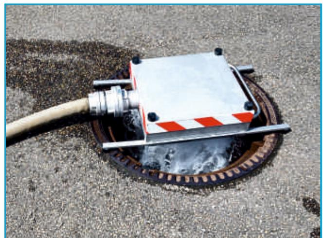
Spülbild bei ca. 130 cbm/Std. Über einer Schachtöffnung 60 cm Durchmesser mit herausgezogenen Füßen. Fast 100% fließt in die Schachtöffnung, gleichzeitig wird der Kanal gespült
