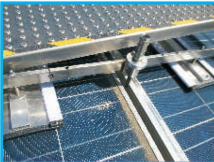
Automatisch einrastende Klickmatik Sicherungsbolzen (zwischen 2 Modulen) mit Kantenschutzoberfläche. Die Klickmatik Sicherungsbolzen sind am Rahmen verstellbar und machen das Novoprimus Panelboard deshalb unabhängig von der Formatgröße des Solarmoduls.
