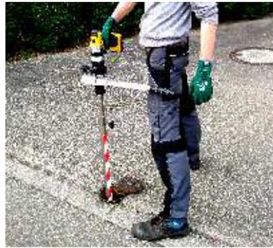
Drehmomentabstützung mittels Anlehnposition
