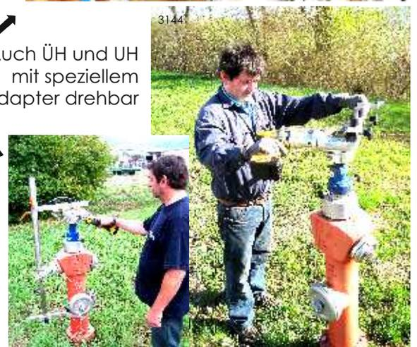
Mit und ohne Drehmomentstütze einsetzbar
