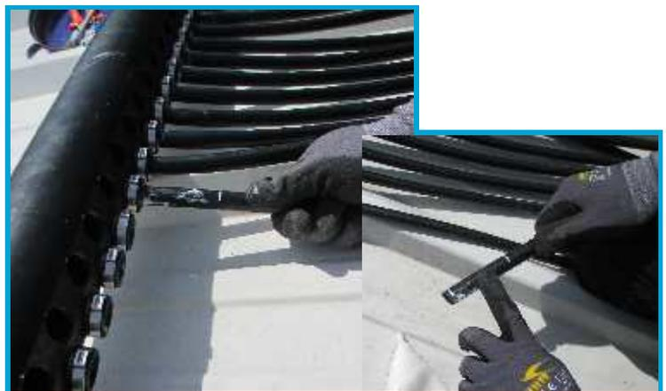
Aplique un poco de lubricante autorizado para tuberías de agua potable (se suministra jabón en pasta en el volumen de suministro) en el extremo de los tubos y el manguito de conexión. Esto permite introducir y ajustar fácilmente los tubos
