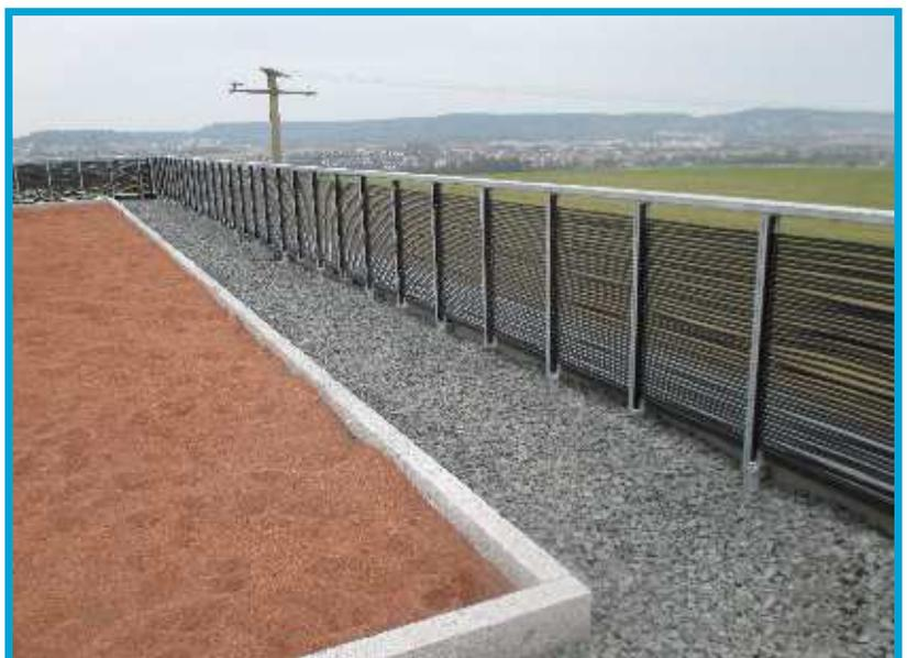
Vallas de absorción como sistema de baranda con función de protección visual, por ejemplo, para la regeneración de sistemas de banco de hielo u otras aplicaciones (con tubos de PE especiales)
