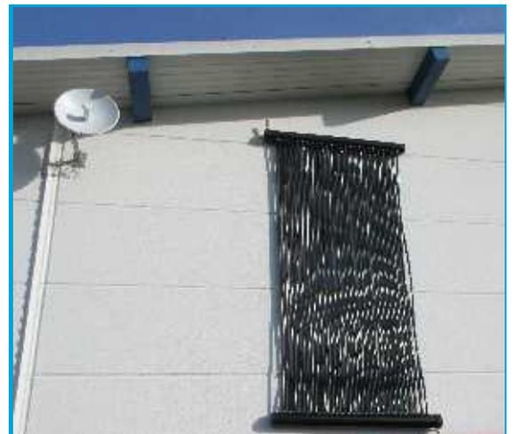
Alta resistencia a la tracción de 200 kg/m para el montaje suspendido
