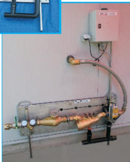
Das auf einer Edelstahlplatte vorgefertigte Installationssystem (Wasser/Elektro) für die Wandinnenseite ist sehr schnell und montagefreundlich anzubringen und anzuschließen. Auch der elektronische Steuerschrank ist steckerfertig vorbereitet.
