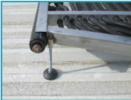
4 patas regulables para ajustar la inclinación en techos planos o similares, entre otras cosas, para facilitar el drenaje del absorbedor
