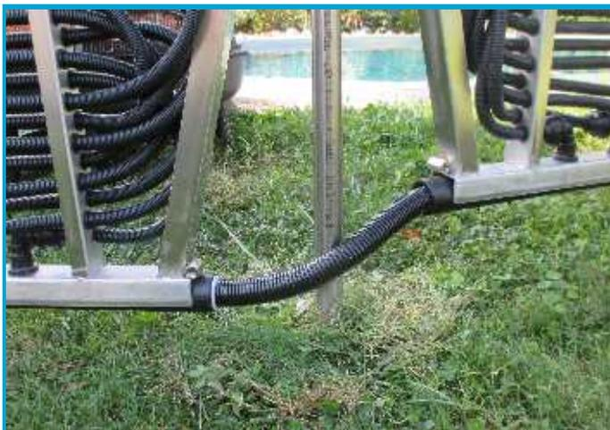
Los tubos de conexión flexibles permiten la compensación de la altura en función del nivel del terreno
