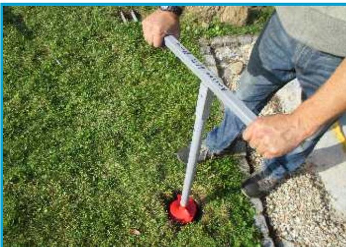
Para la excavación de los cimientos de los postes de la tubería, en caso de un montaje en forma de valla, solo se necesita un taladro de tierra manual de 120 mm. El agujero a rellenar con hormigón debe tener una profundidad de 80 cm. El taladro se puede adquirir o alquilar gratuitamente (opción: excavación a mano 40x40x80 cm)
