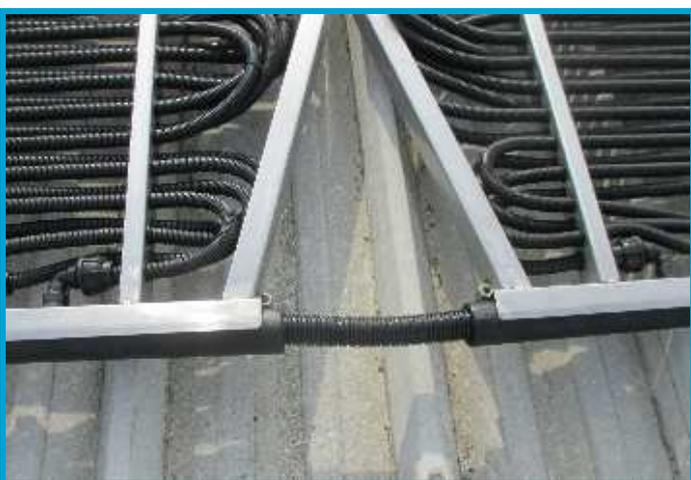
Los tubos de conexión flexibles están hechos de plástico resistente a los rayos UV y a las heladas. Se conectan herméticamente a los tubos distribuidores / colectores con las abrazaderas de acero inoxidable suministradas y se fijan con tornillos para evitar su extracción
