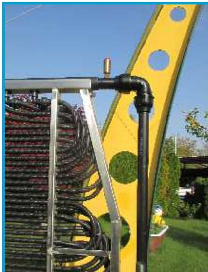
Lo mismo ocurre con el flujo de retorno que corre paralelo detrás de los soportes. La conexión de purga y ventilación está siempre en el punto alto, ya que se puede girar
