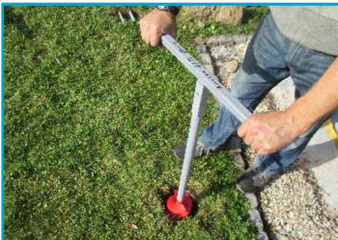
Lo scavo di fondazione per i montanti tubolari che servono installare il sistema con funzione di recinzione, si può eseguire con una semplice trivella manuale da 120 mm di diametro. La profondità del foro per la gettata di cemento deve essere di 80 cm. La trivella si può noleggiare gratuitamente o acquistare (in alternativa: scavo da 40 x 40 x 80 eseguito a mano)
