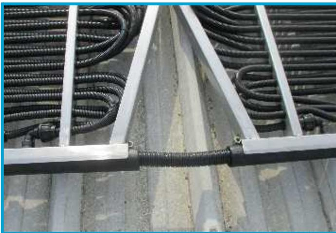
I tubi di raccordo flessibili, in materiale sintetico resistente ai raggi UV e al gelo, si collegano ai collettori di distribuzione con le fascette stringitubo in acciaio inossidabile a corredo che, una volta applicate e avvitate, impediscono lo sfilamento e garantiscono una perfetta tenuta.
