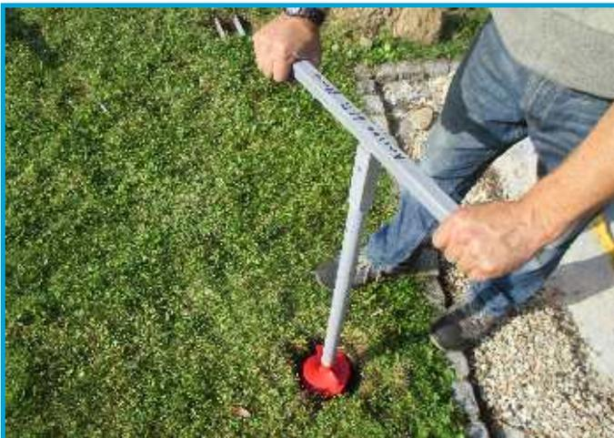
Für den Fundamentaushub der Rohrpfosten bei der Aufstellung als Zaun, genügt ein Hand-Erdbohrer 120 mm Ø. Die mit Beton zu füllende Bohrung muss 80 cm Tiefe betragen. Der Bohrer kann entweder kostenlos ausgeliehen, oder gekauft werden (Alternativ Handausschachtung 40x40x80 cm)
