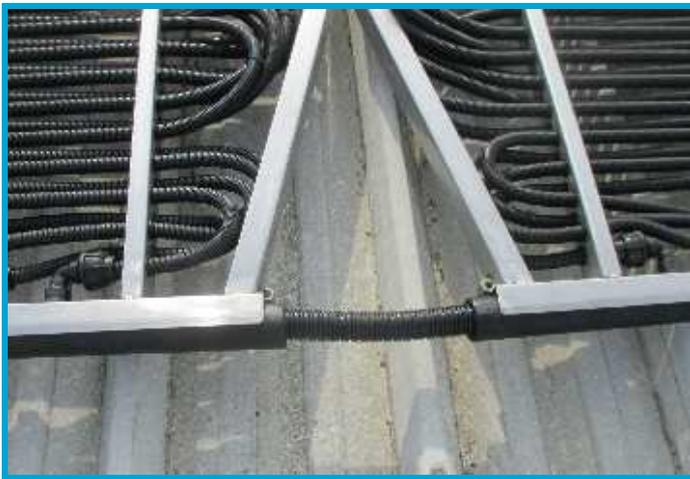
Die flexiblen Verbindungsrohre bestehen aus uv- und frostbeständigem Kunststoff und werden mittels den mitgelieferten Edelstahl-Klemmschellen an den Verteiler-Sammelrohren in einfacher Weise verbunden
