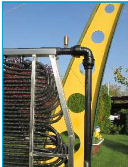
Dto. bei Rücklauf parallel hinter dem Rohrpfosten verlaufend. Der Be- und Entlüfteranschluss befindet sich immer am Hochpunkt, da er drehbar ist
