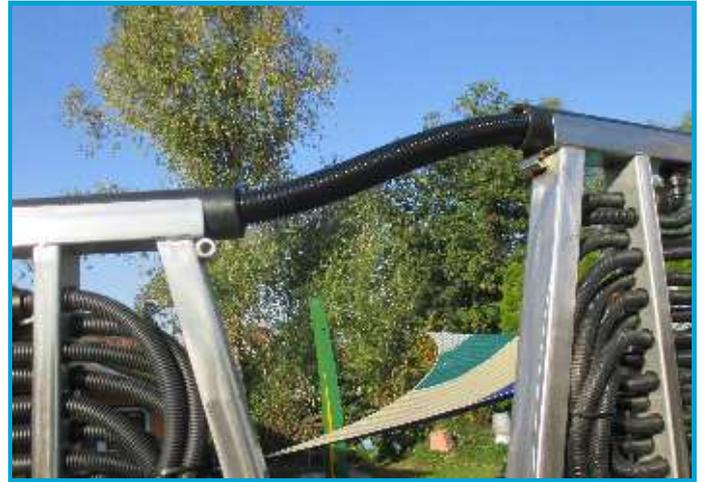
Die flexiblen Verbindungsrohre ermöglichen je nach Geländeniveau Höhenversatz
